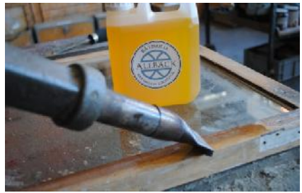
Rauwe lijnolie aanbrengen en verwarmen met een heteluchtfohn
