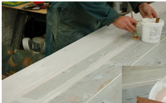
Primer en krijt als onderlaag voor een glad oppervlak
