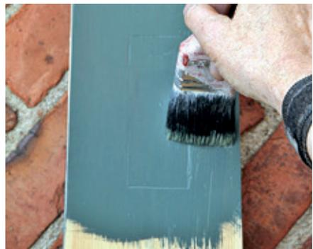
Die Farbe gut in mehreren Richtungen ausarbeiten. In Längsrichtung des Holzes enden.
