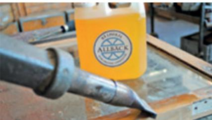
Um das Einziehen zu erleichtern, das Öl mit Heißluft erwärmen. Direkt streichen.
