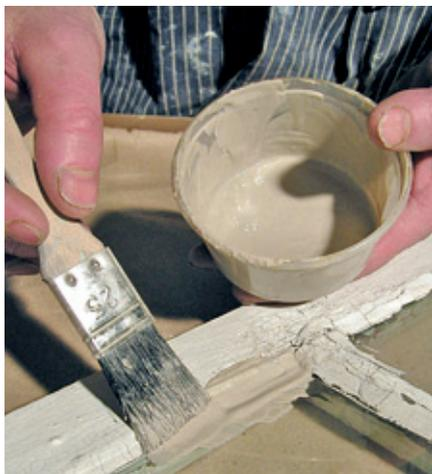
*Le mastic fluidifié, une mesure simple pour retarder le vieillissement.*
