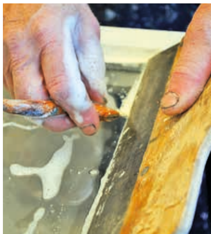
Kantskär kittfalsarna i svagt såpvatten.
