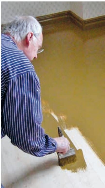
Målning på plastlaminatgolv. Bibehåll penselns vinkel i alla penseldrag.
