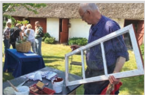
Pålssonhuset, Malmö. Första underhållet efter 30 år.
