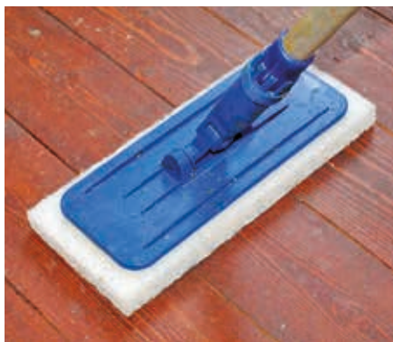
Linoljevax appliceras lätt med sträv skursvamp typ Scotch Brite.
