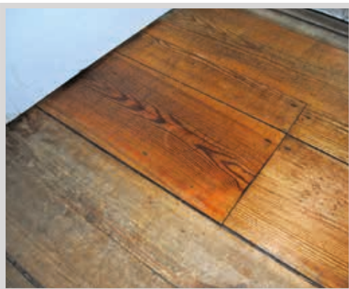
Linoljevax naturell på gammalt trä. Före/Efter behandling.
