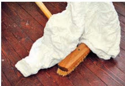
Torka bort överskottet med frottéhandduk.
