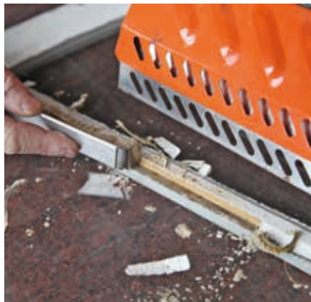
Kittlampa för kittborttagning. Den kan även användas för färgborttagning i begränsad omfattning.
