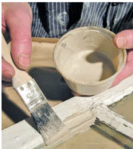
Kittvälling, enkel "fördröja åldrandet" åtgärd.
