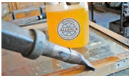
Värm in oljan med hetluft. Måla direkt.
