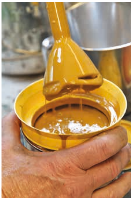
Rör upp färgen nogga med t.ex. stavmixer.
