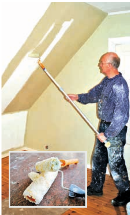
Målning av tapetserade väggar med garnrulle. OBS! Rullen ska rulla lätt!
